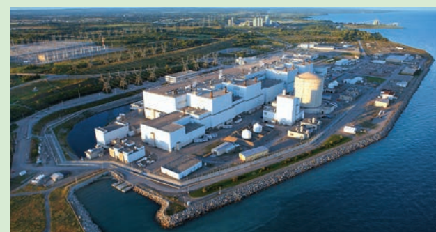
▲ダーリントン原子力発電所 全体像
